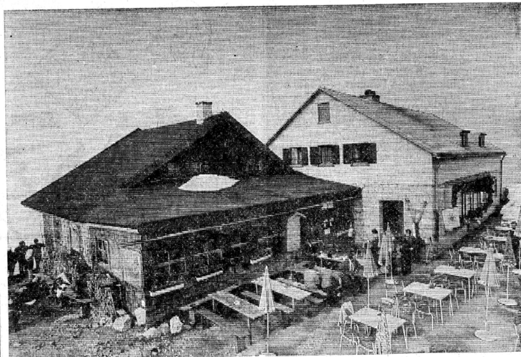
Die zuletzt investierten 250 000 Mark wurden in erster Linie für Ver- und Entsorgung des Hochries-Gipfelhauses verwendet. Links im Bild die alte Hütte, rechts dahinter das seit gut zehn Jahren bestehende Hauptgebäude. Fotos: Berger
